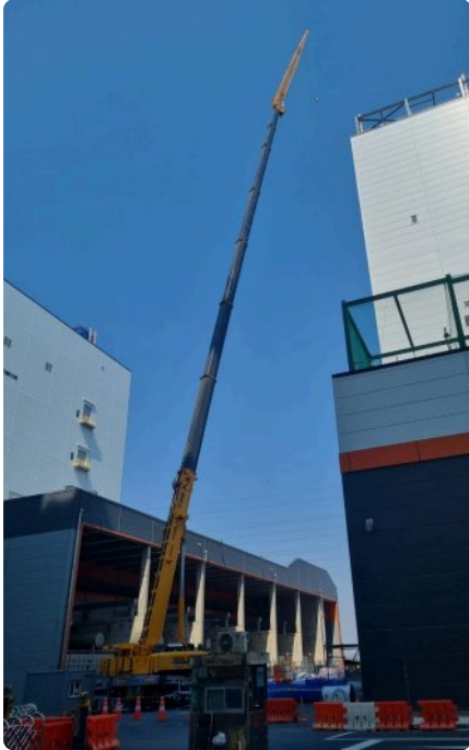
*청주 SK 현장 약 120M 높이 작업반경 70M 메인붐 82.1M + 픽스집 38M
