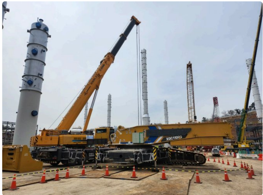
*울산 사힌 프로젝트 현장 XCMG 크롤러크레인 700톤 해체 작업
