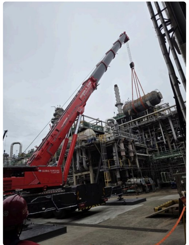
*GS칼텍스 현장 메인붐 39.5M 작업반경 24.4M 중량물 62.1T 인양
