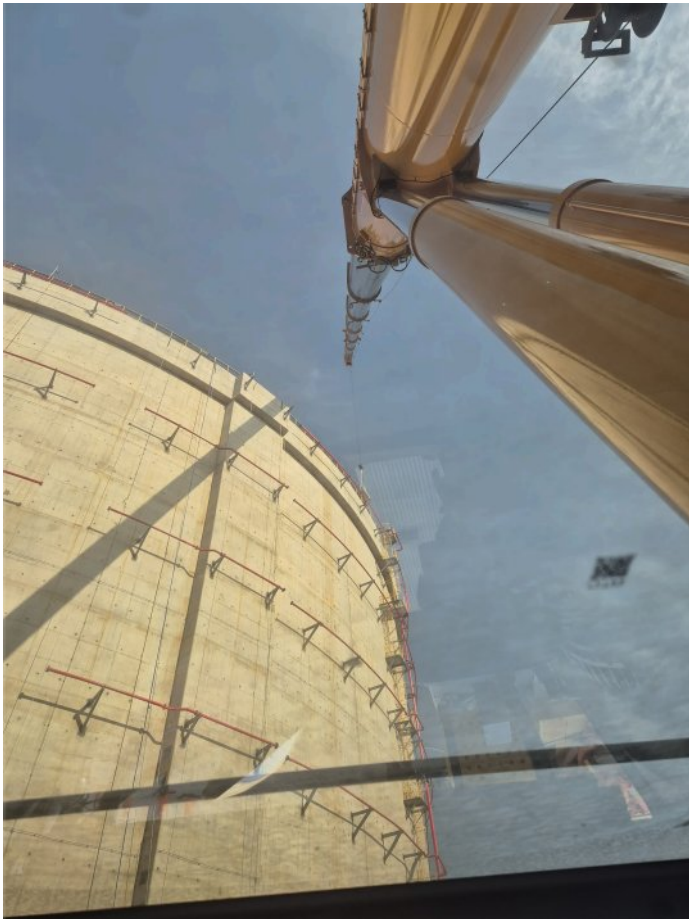
*광양 LNG 탱크터미널 신축공사 조종석 시점 메인붐 85.9M 작업반경 47.1M
