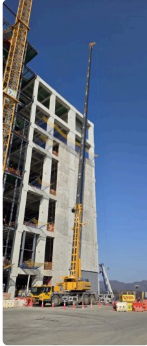
*용인 SK 현장 메인붐 88M + 보조집 16.5M
