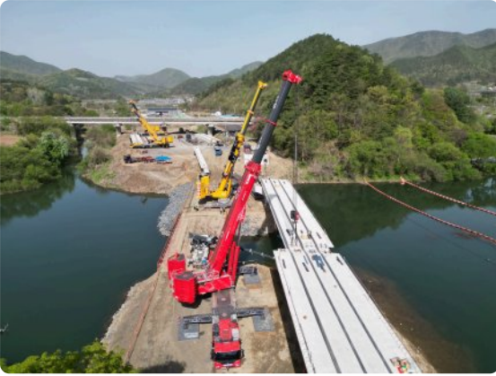
*괴목 교량 동시 작업 XCMG 1000톤, XCMG 450톤 2대, Liebherr 700톤 동시 작업
