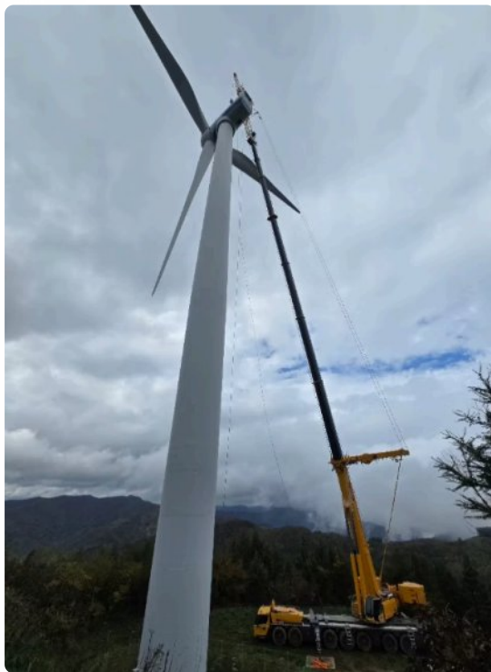
*태백 귀네미풍력 수리 가이드 작업 메인붐 76.7M + V붐 16M + 픽스집 10.5M 중량물 10.5T 인양
