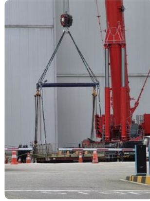
*삼성 반도체 현장 메인붐 97M 가이드 장착 작업반경 19.5M 양중능력 77.2T
