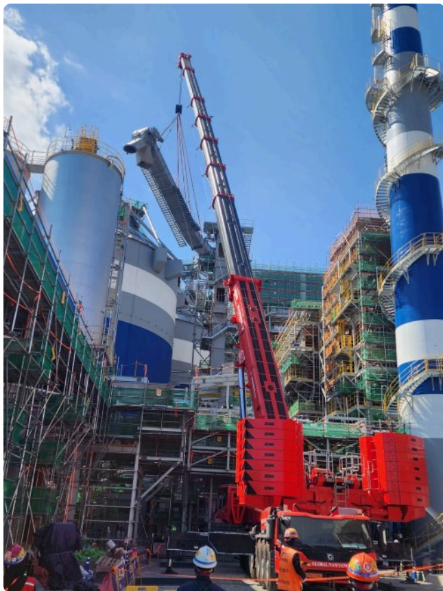
*LG화학 현장 메인붐 68M 작업반경 37M 중량물 27T 인양
