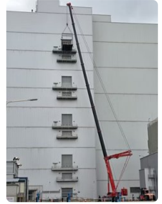
*삼성 반도체 현장 메인붐 97M 가이드 장착 작업반경 19.5M 양중능력 77.2T
