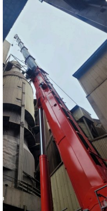
*동해 시멘트공장 기존 500톤 러핑작업 대체 → 메인붐만으로 작업
