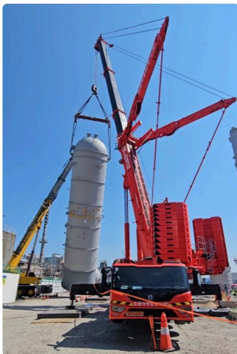
*태광산업 현장 메인불 45M 가이드 장착 중량물 125T 인양
